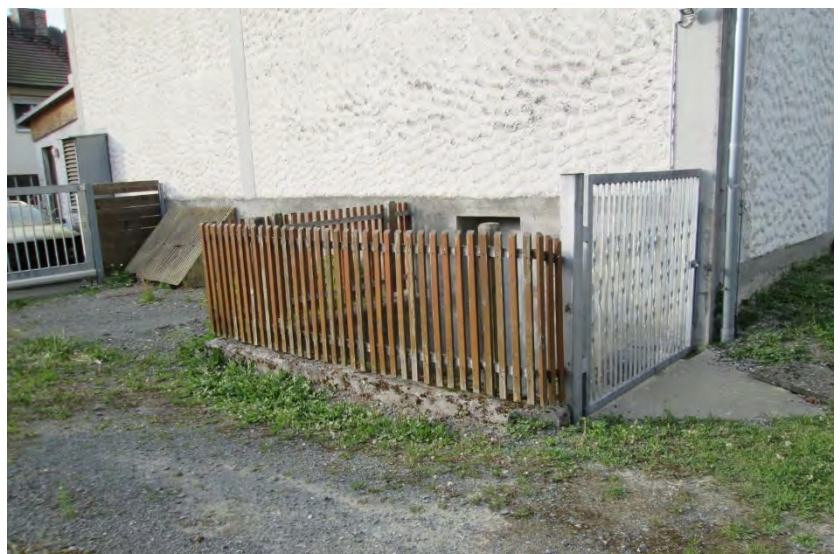
Abb. rechts: Anbauten Süd-West-Fassade
