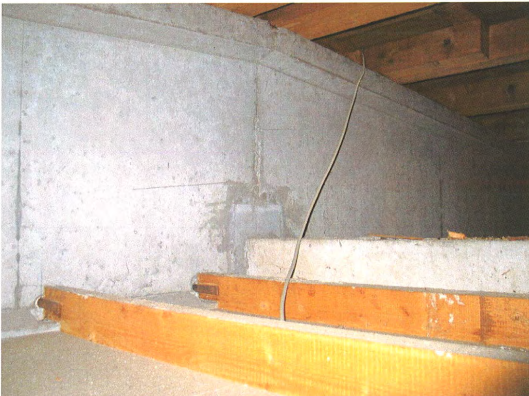
Bild 20: Feld 5, Blick Richtung Osten
