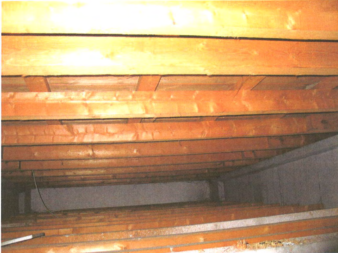
Bild 21: Feld 5, Blick Richtung Süden
