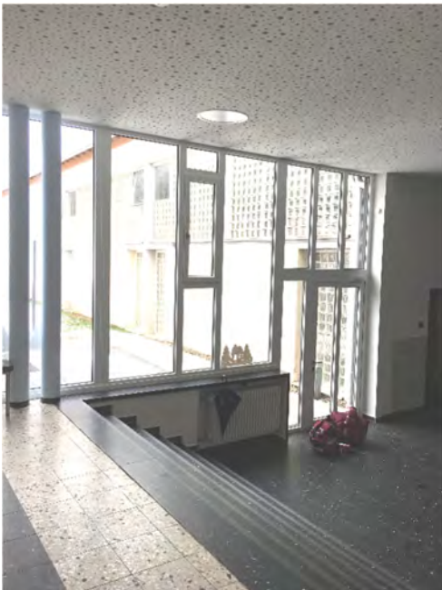
Abb. oben: neuer behindertengerechter Zugang zur Halle über das Pausenfoyer der Schule Abb. unten: neue Fassade von Innen
