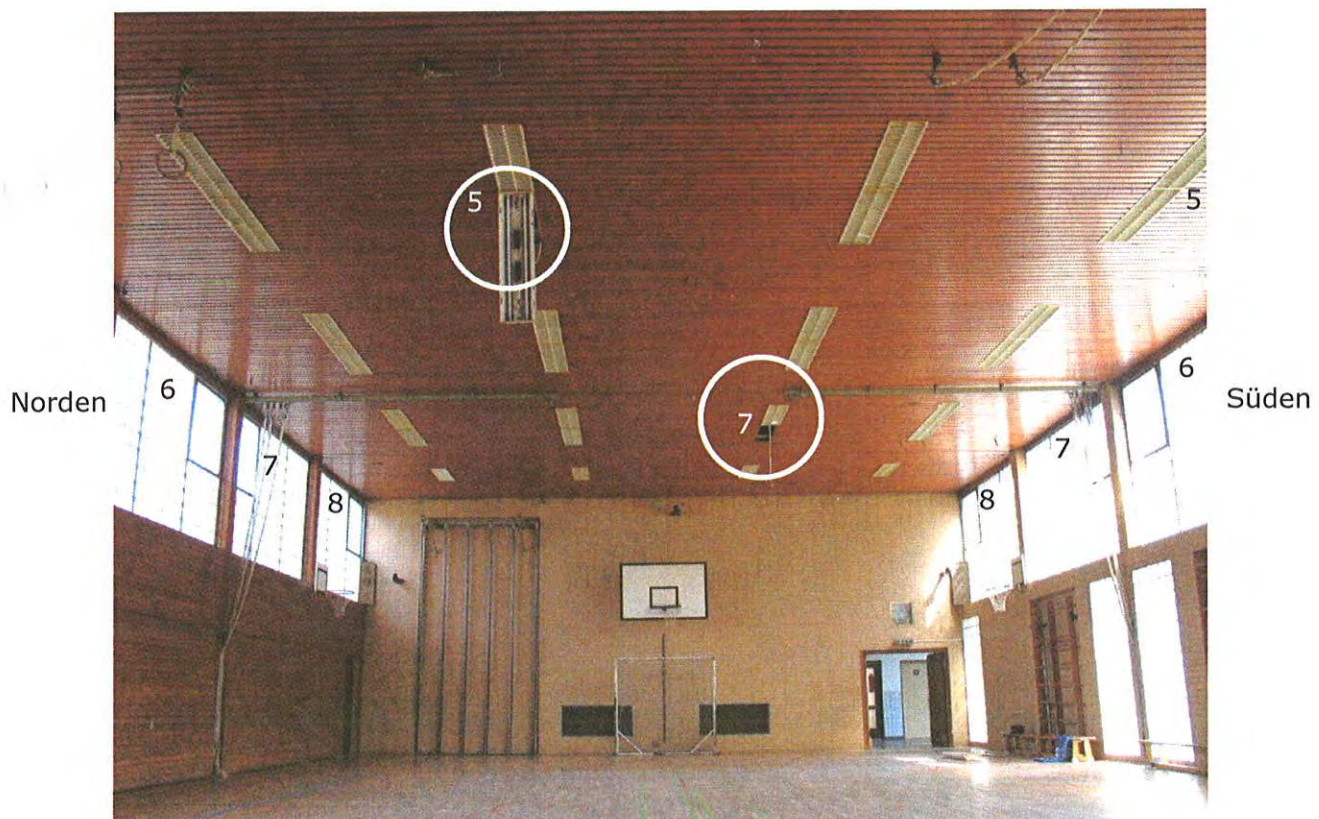
Bild 11: Blick nach Osten: Turnhalle Feld 5 bis 8
