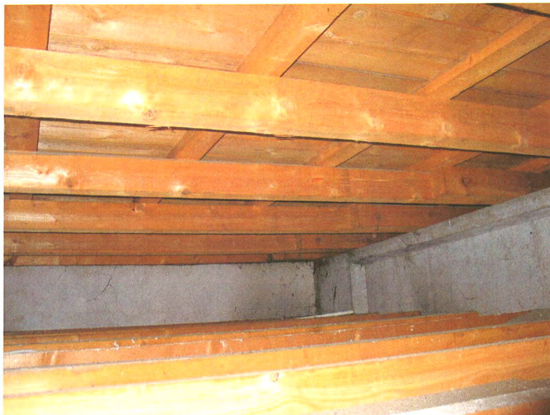
Bild 22: Feld 7, Blick Richtung Südwesten
