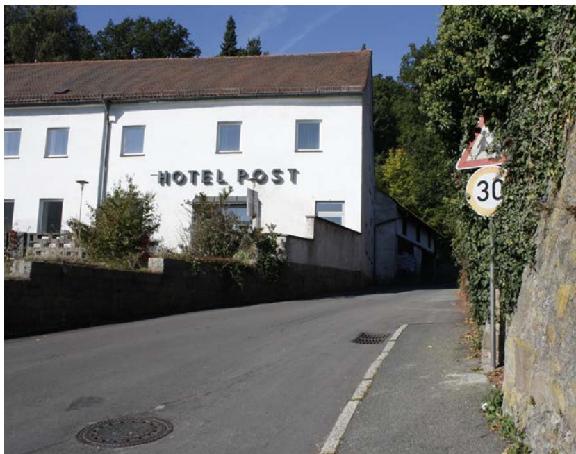
Die beiden anstehenden Projekte der Städtebauförderung sind die Gestaltung der Regensburger Straße (linke Seite) und die Entschärfung des Abzweigs in die Mittelschulstraße.
