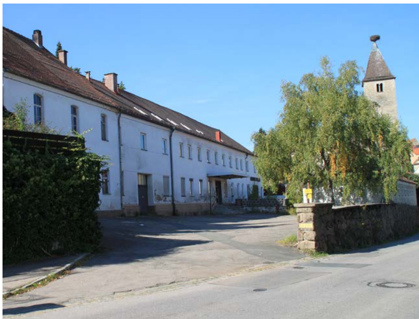
Mit den Abbrucharbeiten wurde im Herbst 2015 begonnen.
