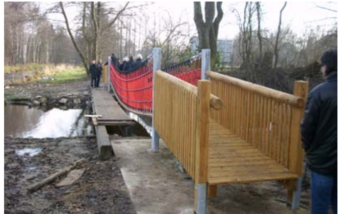
Freiflächengestaltung Anger und Egerufer Bauabschnitte I - III, 2007-09
