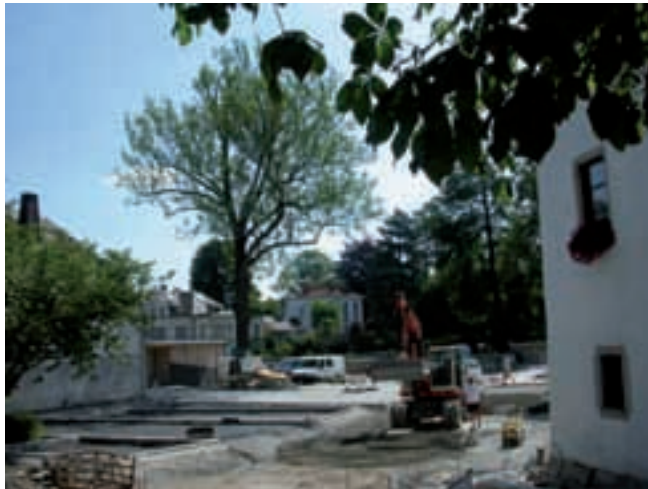
Oben: Baustelle der Umfeldgestaltung
