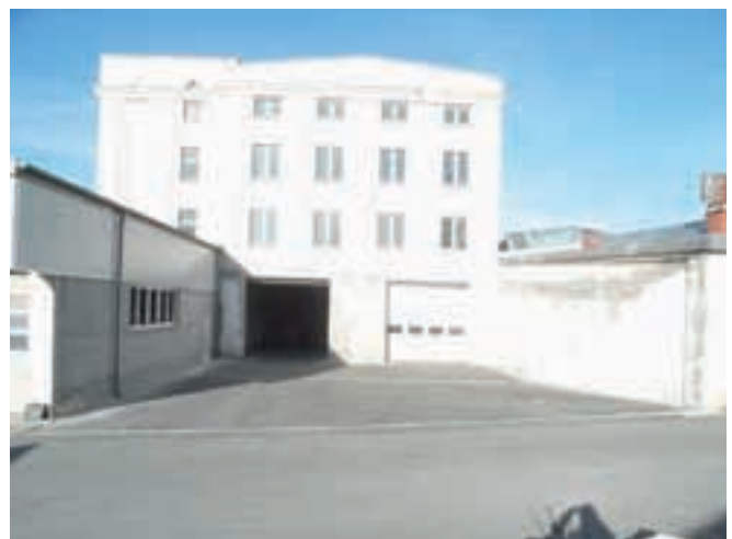
Oben: Errichten von Brandschutzabschnitten im Bestand
