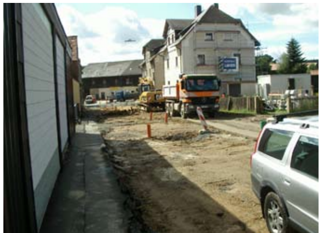
Oben: Unterbauarbeiten im Mündungsbereich Jahnstraße Mitte: Private Fassadenrenovierung, die mit der Straßenbaumaßnahme einhergeht
