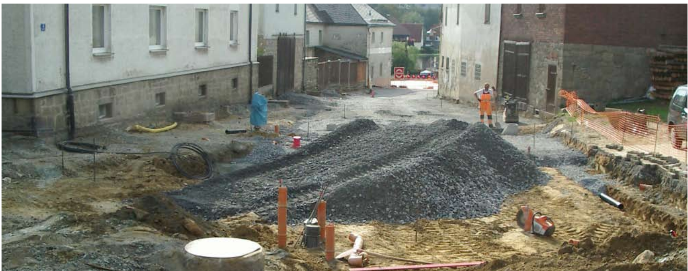
Unten: Vor der Oberflächengestaltung wird die unterirdische Infrastruktur angepasst. (Fotos: Stadt Kirchenlamitz)
